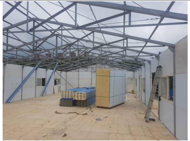
照片說明：假設工程(搭設工務所)
