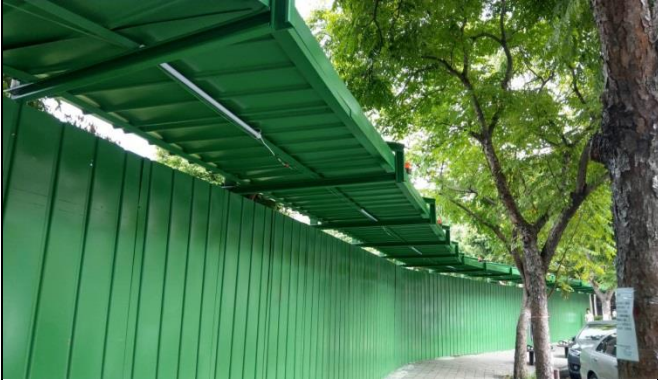
照片說明：假設工程(搭設圍籬及安全走廊)
