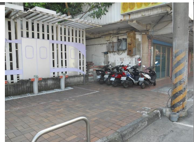
切開圍籬後裝設接送區側門。
