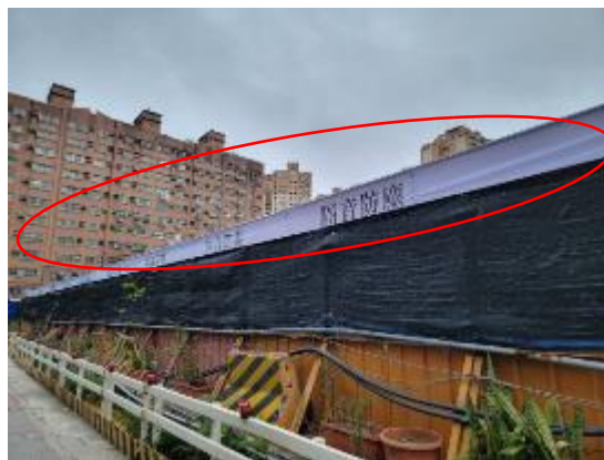
隔音防塵帆布安裝完成
