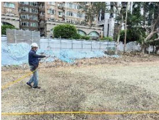
定期鋪面灑水抑制粉塵
